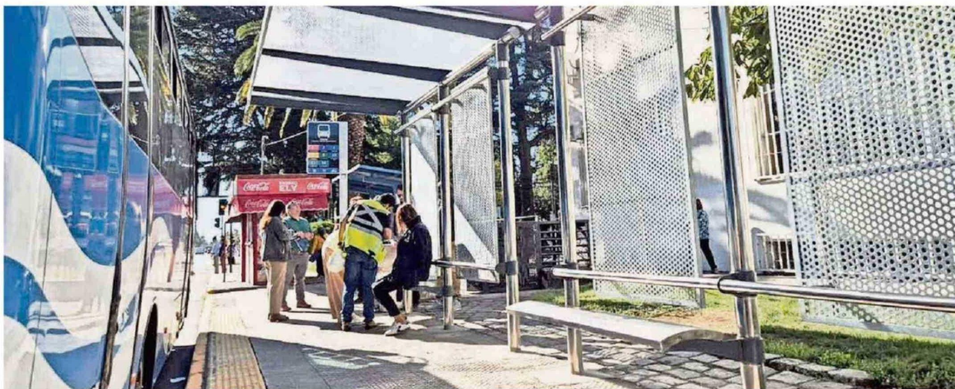
EQUIPO TÉCNICO INSPECCIONÓ UNO DE LOS 23 PARADEROS INTERVENIDOS EN DISTINTOS PUNTOS DE CHILLÁN.
