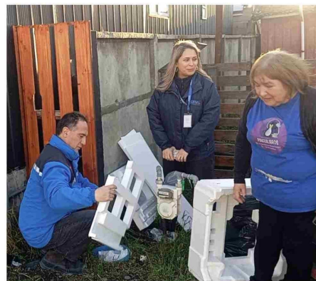
Entre las recomendaciones para el invierno se encuentra proteger los nichos de los medidores con plumavit.
