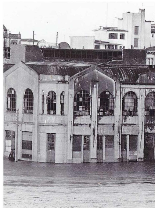
EL TERREMOTO Y POSTERIOR TSUNAMI AFECTÓ TODA LA COSTA DEL CENTRO-SUR DE
