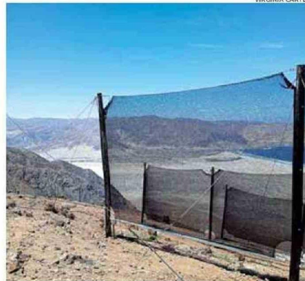
DOS POSTES SOSTIENEN LA MALLA CENTRAL QUE ATRAPA EL AGUA.
