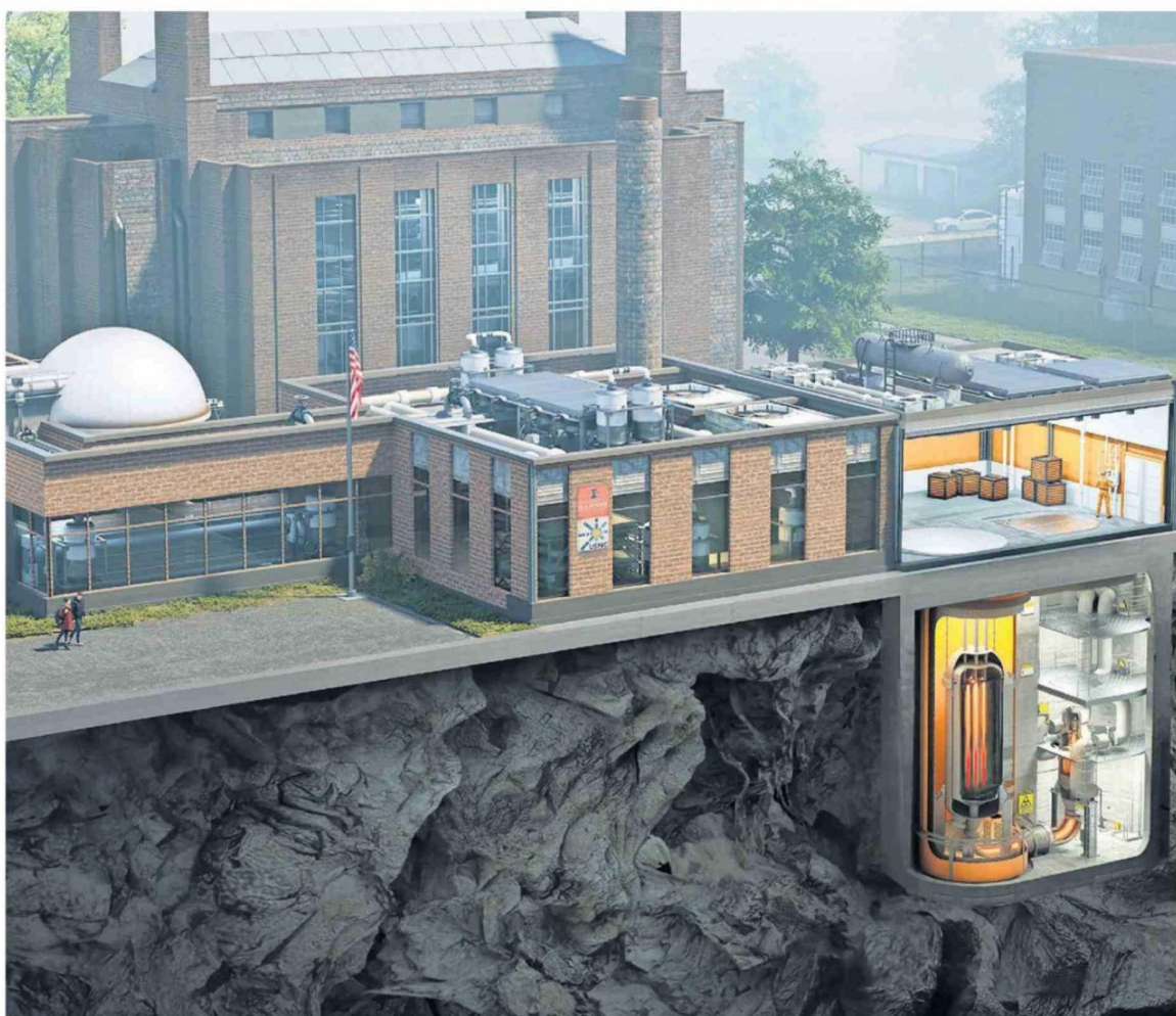
Ilustración conceptual del aspecto que podría tener una central nuclear de Reactores Modulares Pequeños situada en una zona más urbana.
