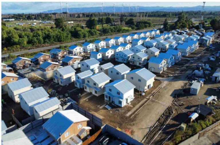
EL AVANCE DE LAS OBRAS de construcción superó el 56%, con una entrega proyectada para 2026.
