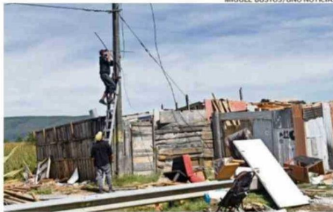
DURANTE LA SEMANA SE LOGRÓ EL DESARME DE LAS VIVIENDAS.
