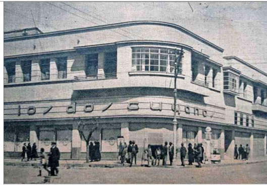
Tras el terremoto, la arquitectura moderna entró de lleno en una sociedad aún anclada en el antiguo entorno neoclásico.
