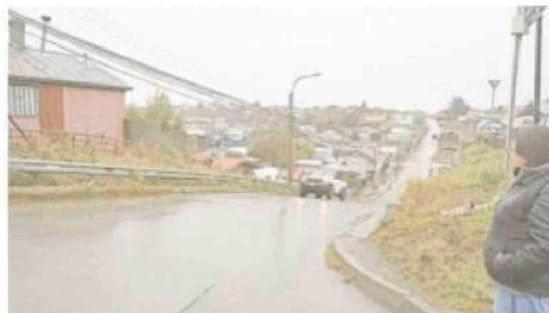
La calle Ramón Carnicer, donde la pendiente y la escasa visibilidad impiden anticipar el tránsito en ambos sentidos.
