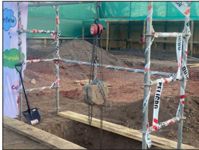
Colocan primera piedra del nuevo Cesfam de Curimón.
