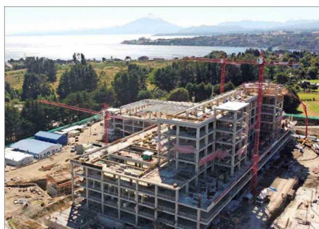
OBRAS.— El hospital de Puerto Varas, con 31% de avance, estuvo paralizado por hallazgos arqueológicos por más de un año junto a otros tres recintos.
