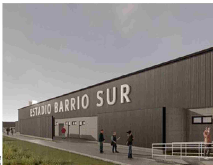
El Instituto Nacional de Deportes (IND) de Magallanes anunció la aprobación definitiva para la construcción del nuevo Estadio del Barrio Sur.
