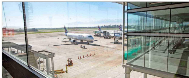
MAYOR CAPACIDAD. — A partir de septiembre, habrá 38 puertas operativas en el embarque nacional de Nuevo Pudahuel. Actualmente son 22.
