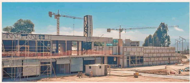
Con una inversión de US$ 5,5 millones, el centro comercial Marbella Alcazaba registra un avance de 80% y su apertura se proyecta para el segundo semestre.
