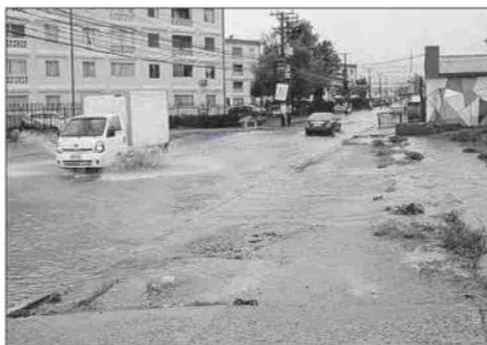
Las calles de Villa Alemana se vieron fuertemente afectadas por las lluvias.
