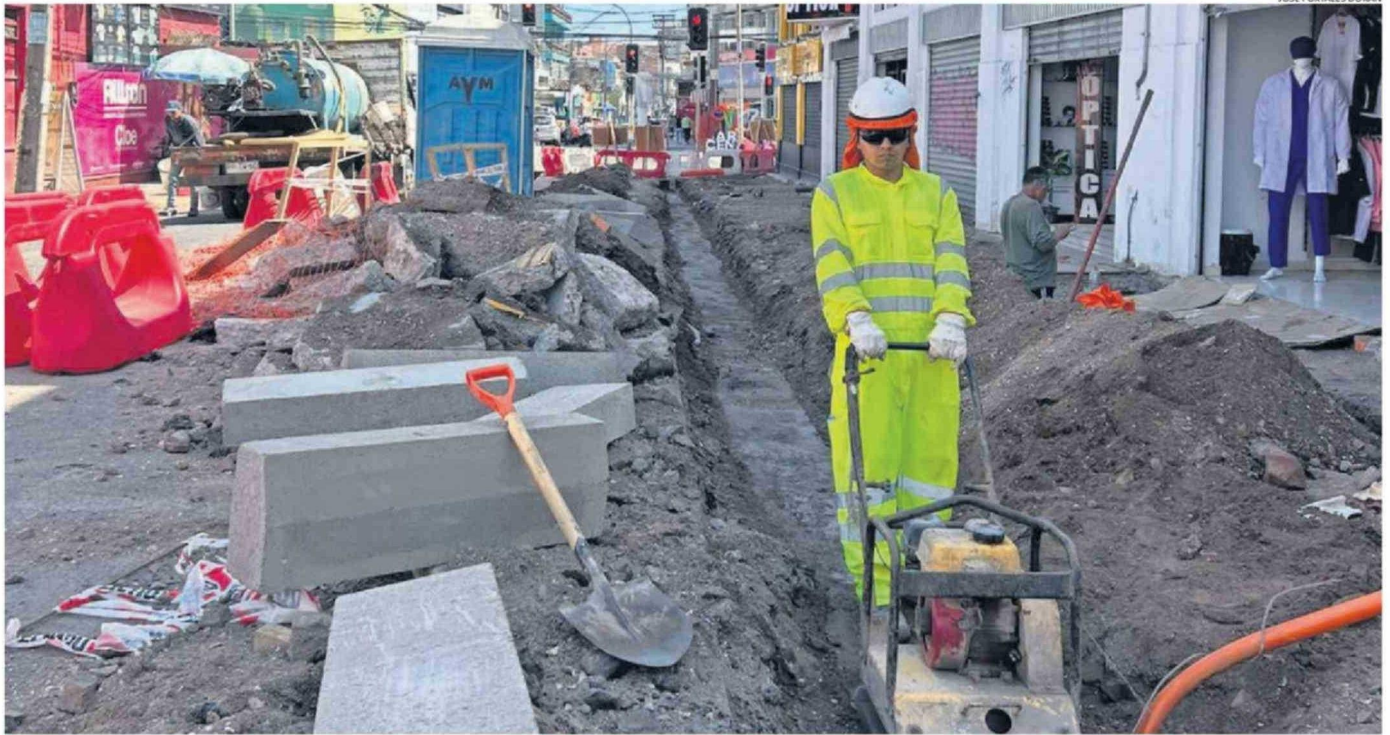
LA EMPRESA CONTRATISTA, QUE ESTÁ REALIZANDO LOS TRABAJOS EN EL SECTOR, ESTÁ AVANZANDO CON EL HORMIGONADO EN LA CALLE ALMIRANTE LATORRE, ENTRE BARROS ARANA Y VIVAR.
