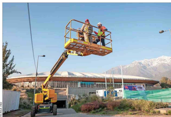
También habrá arreglos en los exteriores, para mejorar la recolección de precipitaciones, mientras que se retirarán pilares que ya no se utilizan.
