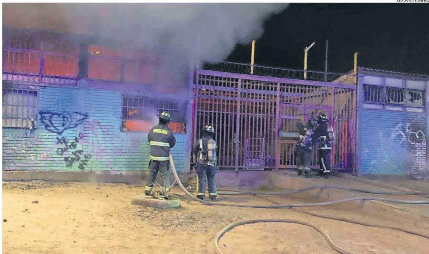
PESE AL INCENDIO QUE AFECTÓ UNA PARTE DEL JARDÍN INFANTIL Y SALA CUNA LOBITO MARINO, AYER EL EDIFICIO SEGUÍA TOMADO DE FORMA IRREGULAR Y CON MOVIMIENTO EN SU INTERIOR.
