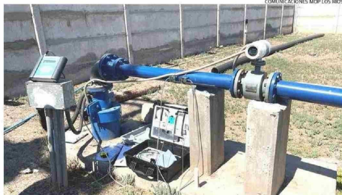
EN TOTAL LA DGA CONSTRUIRÁ 19 ESTACIONES DE MONITOREO DE AGUAS SUBTERRÁNEAS EN LOS RÍOS.
