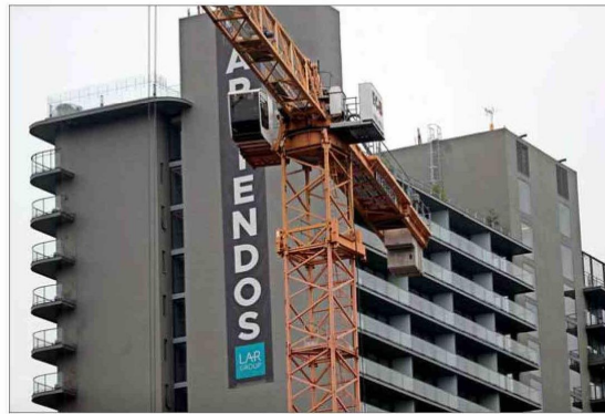
Santiago, Estación Central y La Florida concentran los departamentos.
