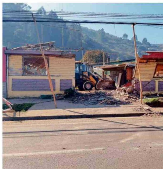
EL PLAZO DE CONSTRUCCIÓN ES DE 210 DÍAS.
