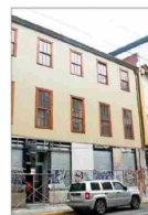
En medio del deterioro urbano de Valparaíso, privados restauran inmueble de 1864 en el sector céntrico del puerto. | C 9
