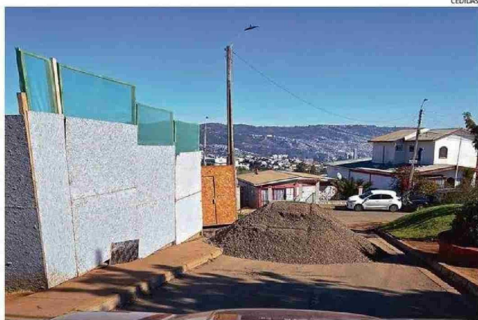
EN LA VILLA ACUSAN EL DEPÓSITO FRECUENTE DE MATERIALES DE CONSTRUCCIÓN EN LA CALLE.
