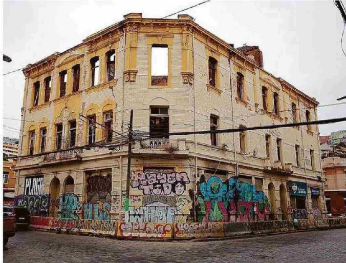
EL DETERIORADO ESTADO DEL BARRIO PUERTO GRAFICA LA PROBLEMÁTICA QUE AFECTA A VALPARAÍSO.
