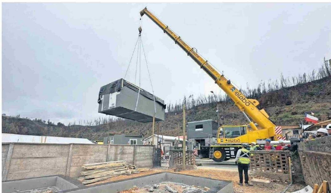
En Lirquén y Punta de Parra ya comenzó la instalación de las primeras viviendas definitivas industrializadas durante el mes de abril.
