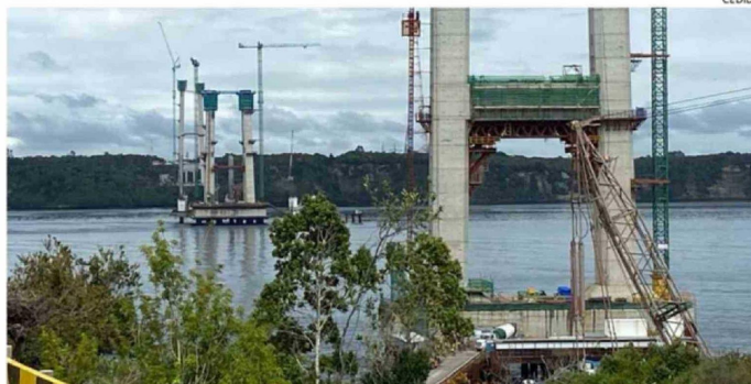
PARA OCTUBRE DEL 2028 ESTÁ PROGRAMADO EL FIN DE LOS TRABAJOS DEL VIADUCTO, LA MAYOR OBRA EN CONSTRUCCIÓN EN CHILE.
