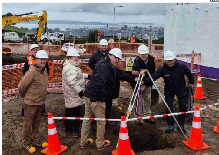
HACE UNOS DÍAS SE REALIZÓ LA INSTALACIÓN SIMBÓLICA DE LA PRIMERA PIEDRA.
