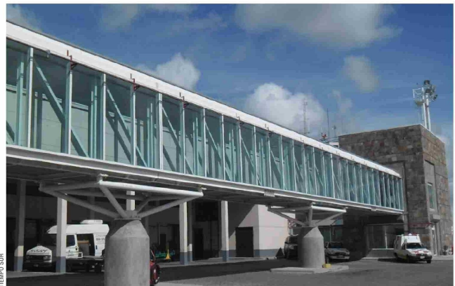
Aeropuertos Argentina llevará a cabo el proyecto de rehabilitación de la pista 07-25 del Aeropuerto Internacional de Río Gallegos "Piloto Civil".
