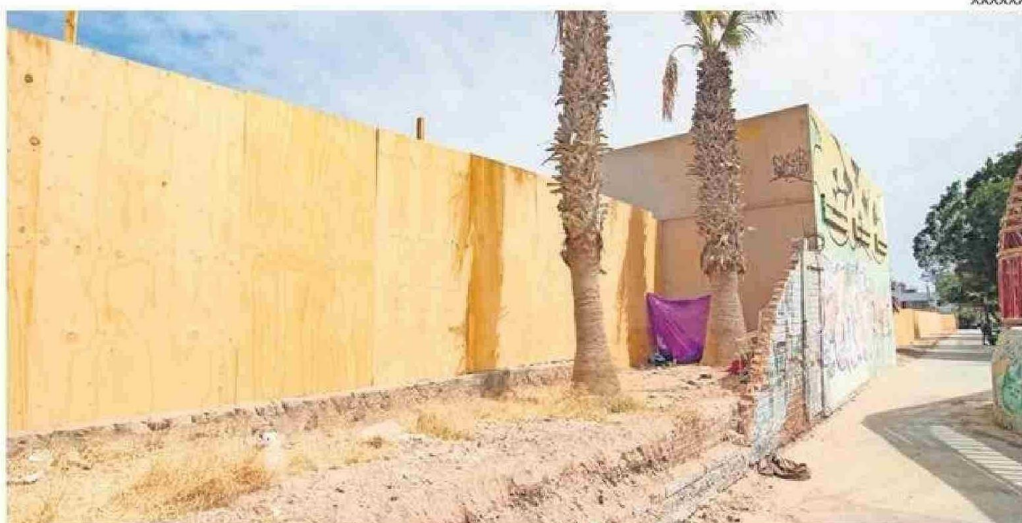
SE INSTALÓ UN CIERRE PERIMETRAL PROVISORIO MIENTRAS SE AVANZA EN EL PROYECTO.S
