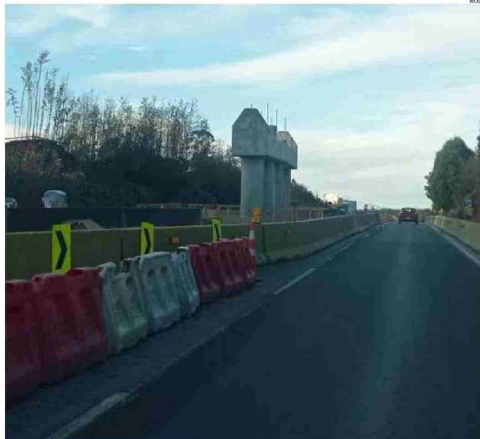
LAS PASARELAS PEATONES YA ASOMAN A LO LARGO DE LA RUTA 5 ENTRE PUERTO MONTT Y PARGUA.
