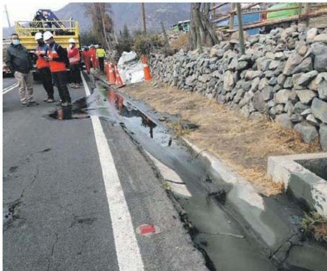
La filtración escurrió a través de canaleta aledaña a la ruta D-835, atravesando por un sistema de conducción de agua de la ruta pública a un terreno particular.
