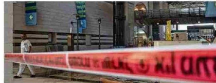
A PESAR DE LOS DAÑOS, EL HOSPITAL SIGUE ATENDIENDO YA QUE ES EL ÚNICO CENTRO MÉDICO DE SU TIPO EN EL DESIERTO DE NÉGUEV.
