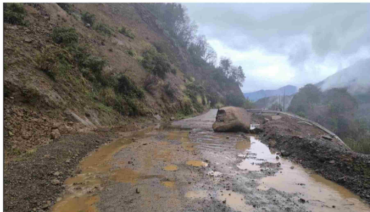
AÚN HAY RIESGO DE DERRUMBES de tierra y rocas en la zona cordillerana.
