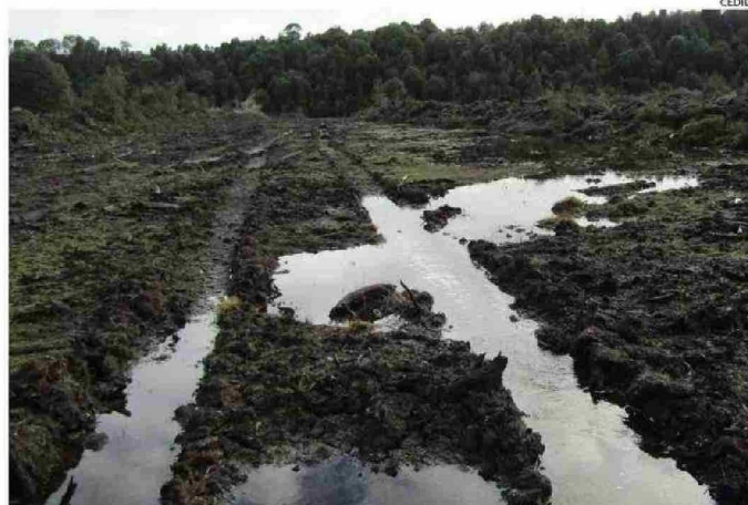
EN EL LUGAR SE HIZO ESCARPADO DEL LECHO Y RIBERAS, ASÍ COMO SE CONSTRUYÓ UN DRENAJE.
