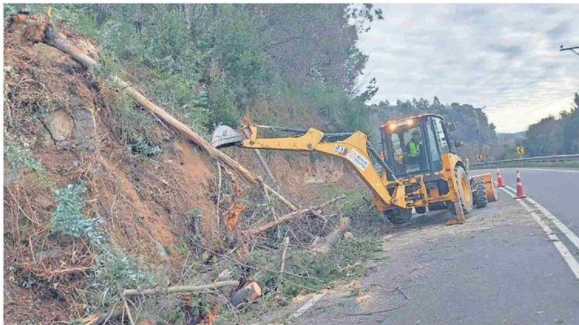
Todas estas acciones se profundizan a nivel local en períodos de fuertes lluvias. Hoy es posible advertir trabajos en Santa Juana y Florida, por ejemplo.
