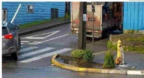
LIBERACIÓN DE AGUA EN GRIFO DE LAS CERCANÍAS AL CESFAM PRODUCTO DE LOS ARREGLOS.
