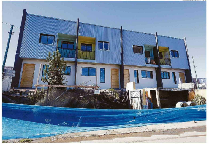
LAS CASAS QUE SERÁN DEMOLIDAS Y RECONSTRUIDAS SE ENTREGARÁN EN DICIEMBRE, ASEGURÓ EL MINVU.
