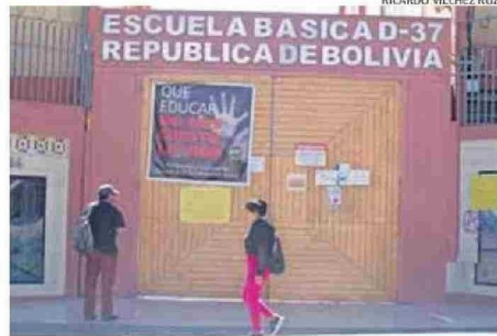
ESCUELA REPUBLICA DE BOLIVIA SUFRIÓ CORTE DE ENERGÍA ELÉCTRICA.
