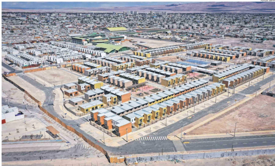
PROYECTO QUEBRADAS DEL LOA FUE ENTREGADO OCHO MESES ANTES DEL PLAZO CONTRACTUAL Y SE ENMARCA EN EL PLAN DE EMERGENCIA HABITACIONAL EN LA REGIÓN.
