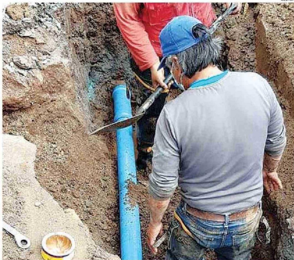
EL PRÓXIMO LUNES 28 PARTEN LOS TRABAJOS EN LA CAPITAL PROVINCIAL PETORQUINA.
