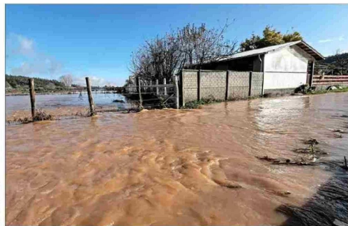
DAÑO. —Una de las zonas más afectadas por el sistema frontal fue Arauco, en la Región del Biobío, por la gran acumulación de agua.
