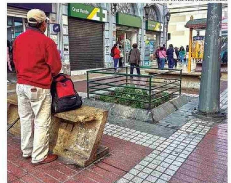
LOS ESCASOS ASIENTOS PRESENTAN UN EVIDENTE DETERIORO.
