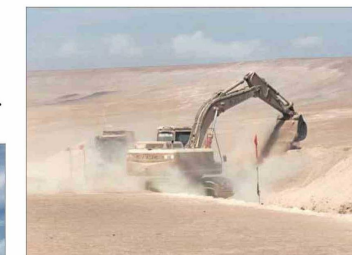
Las retroexcavadoras se encuentran en plena operación en la zona limítrofe con Perú, uno de los puntos por donde entran los indocumentados.
