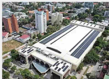
Cencosud cuenta con 9.231 m 2 de paneles solares instalados y en el último año, el 36% de su consumo energético provino de fuentes renovables no convencionales.
