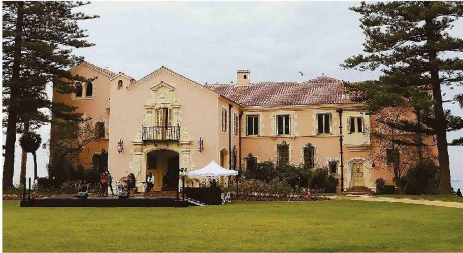
EN 1930, DURANTE EL PRIMER MANDATO DE CARLOS IBÁÑEZ DEL CAMPO, EL GOBIERNO DECIDE LA CONSTRUCCIÓN DEL PALACIO EN CERRO CASTILLO.
