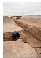
Perú también construye zanjas junto al límite. Uchiliclos cerca del control Santa Rosa, buscan principalmente evitar que los vehículos evadan las fiscalizaciones. | C 11
