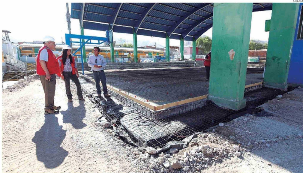
LAS AUTORIDADES DE LA CORPORACIÓN MUNICIPAL SUPERVISAN LAS OBRAS DE CONSERVACIÓN DE LICEOS DE LAS CAPITAL REGIONAL.
