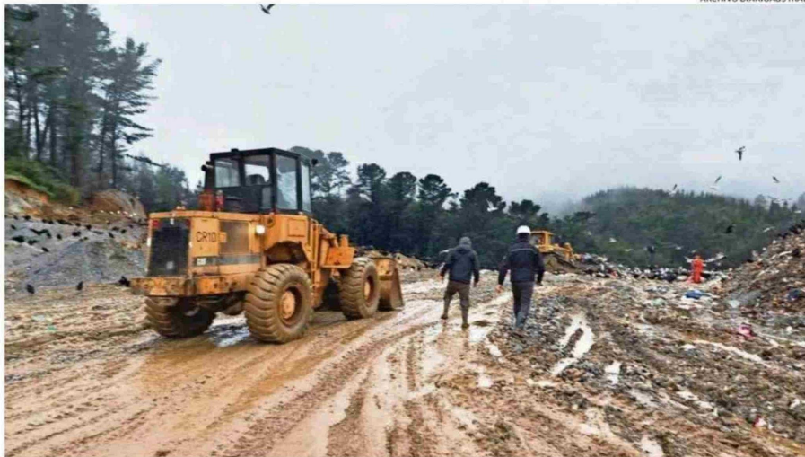
EL TÉRMINO ANTICIPADO DEL CONTRATO DE OBRAS CIVILES EN MORROMPULLI, FUE DECRETADO POR EL MUNICIPIO CON EL DECRETO N°6205 DE 2024.
