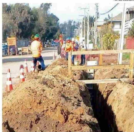
LAS EXCAVACIONES FUERON TAPADAS POR LA EMPRESA.
