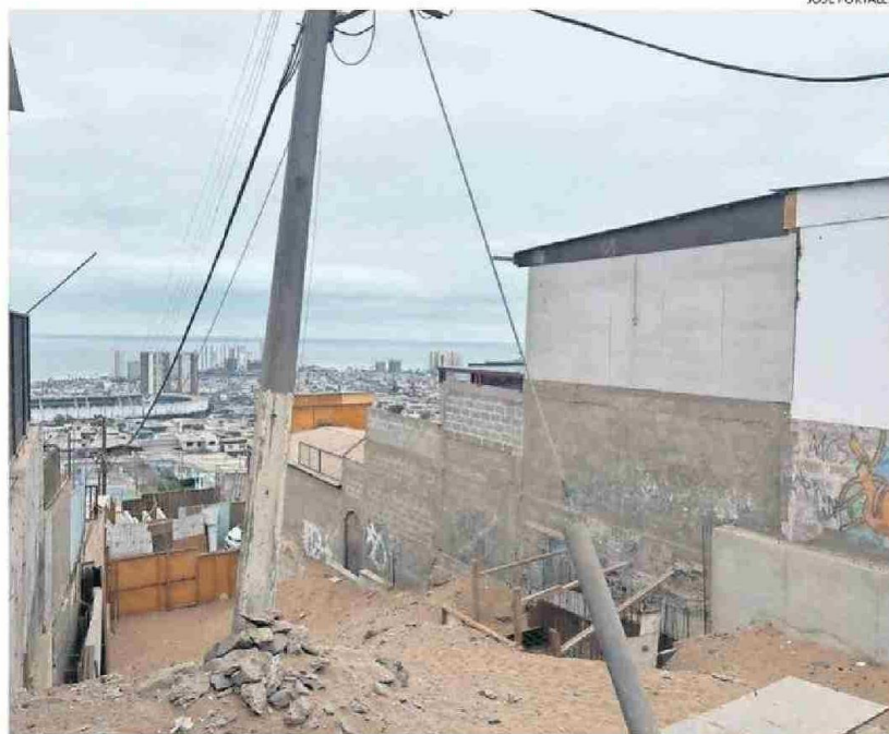
LA OBRA INICIÓ EL 27 DE SEPTIEMBRE DE 2022 POR UNA INVERSIÓN MUNICIPAL DE $443 MILLONES.
